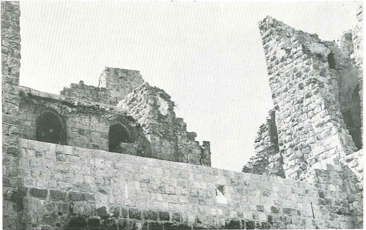
١ - قلعة الرض (عجلون) الواجهة الشرقية بعد الترميم
