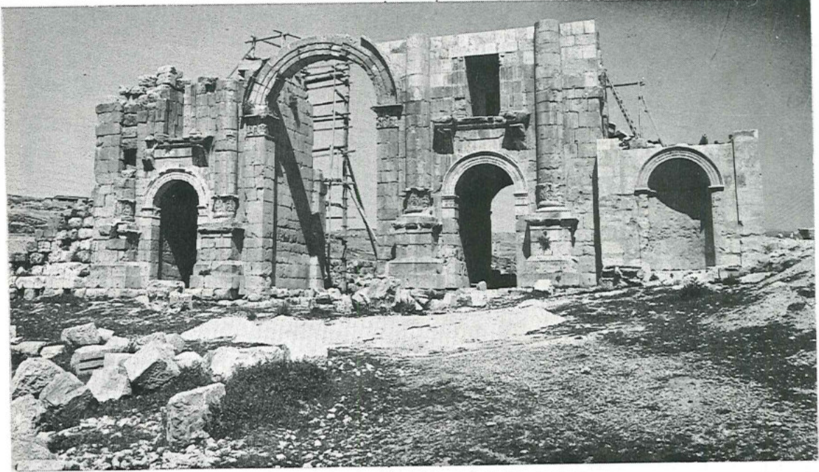
جرش : الواجهة الجنوبية لبوابة عمان بعد انتهاء الترميم
