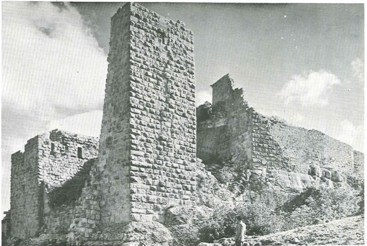
ب - قلعة الرض (عجلون) الواجهة الشمالية قبل الترميم
