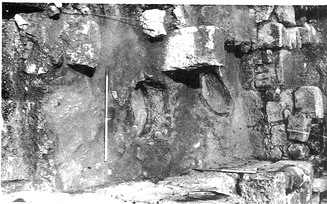
2. le sondage 2 : vue sur le mur externe est
