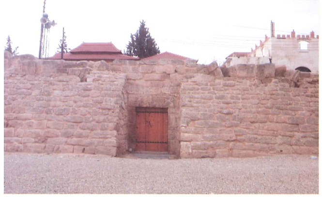
واجهة مسجد القسطل بعد انتهاء أعمال الترميم المرحلة الثانية
