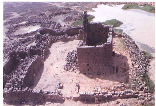
قصر برفق الأثري بعد انتهاء أعمال الترميم المرحلة الأولى
