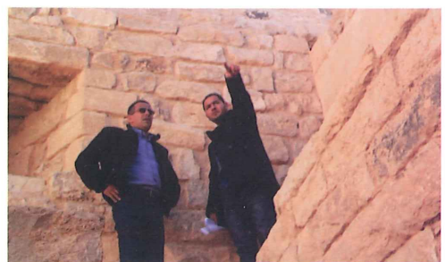
إنهاء المرحلة الأولى من أعمال الترميم لقلعة القطرانة
