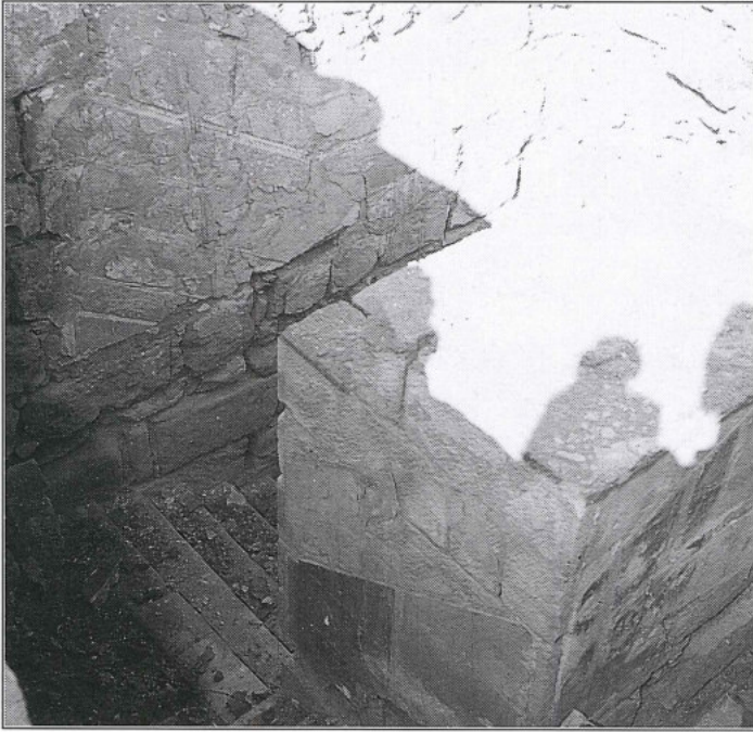
2. Vue en contre-plongée de la cage de l'escalier (A. Barbet).
