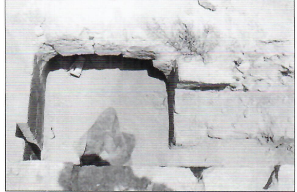
٨. فتحة دخول المياه لقناة بركة القطرانة ويظهر المغلاق.
