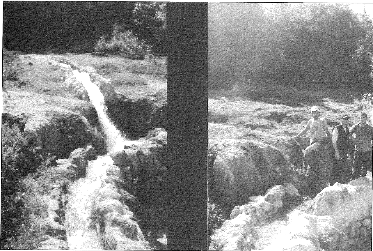
١٧. طاحونة عوده قبل وبعد بناء قناة المياه الداخلة للطاحونة.
