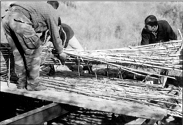
١٠. طاحونة عودة أثناء بناء السقف المنهار.
