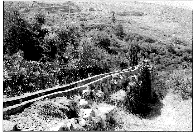
٣. قناة لتزويد طاحونة الحبوب بالماء.
