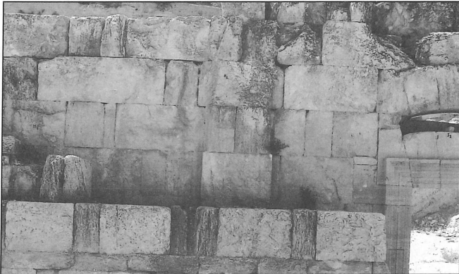
١١. الجدار الخارجي للمسرح يوضح طبيعة المادة المستخدمة في البناء.
