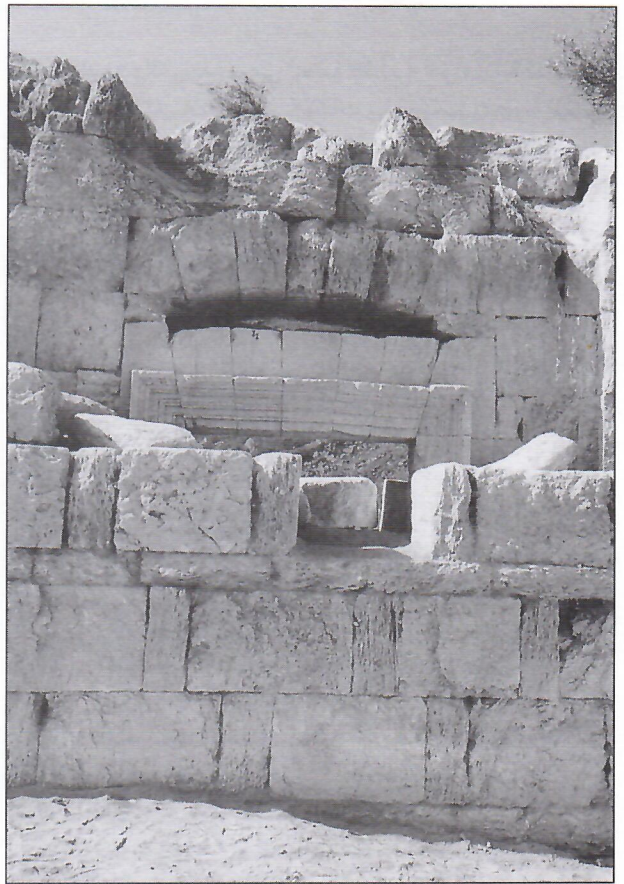
٢١ . المدخل المغلق من الخارج بالجدار الداعم الإضافي.
