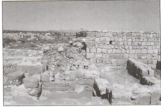
١٧. الجدار الغربي الملاصق للمنزل التراثي قبل الترميم.
