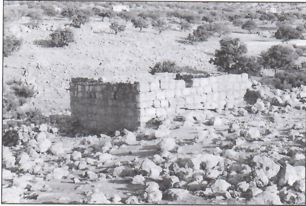
١٥. المنزل التراثي رقم (٢) قبل الترميم والتسقيف.
