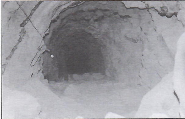
١٠ . أعمال الصيانة والترميم للنفق المؤدي إلى البئر من الداخل.
