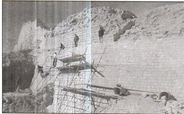
١٦ . الجدار (R11) وجدار الكنيسة الخارجي بعد الترميم.
