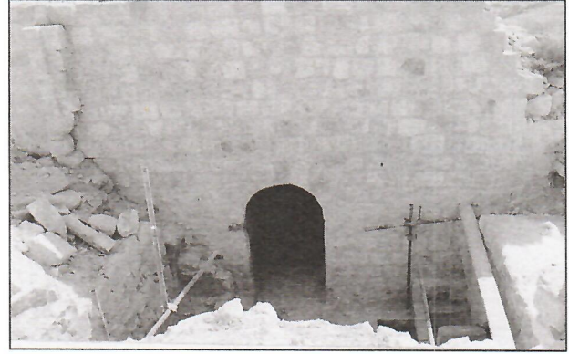
١٢ . واجهة البوابة الغربية من الخارج للكنيسة الجنوبية بعد الترميم.
