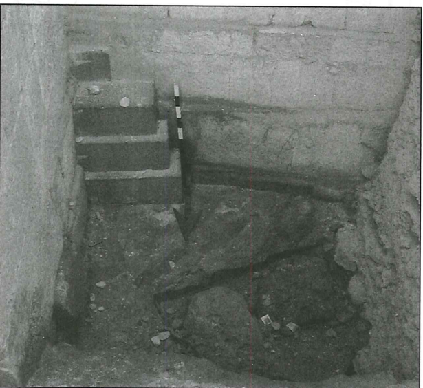
٣١ب. الخندق التأسيسي الذي أعد لبناء الأساس البازلتي ثم البناء بالحجر الطباشيري.
