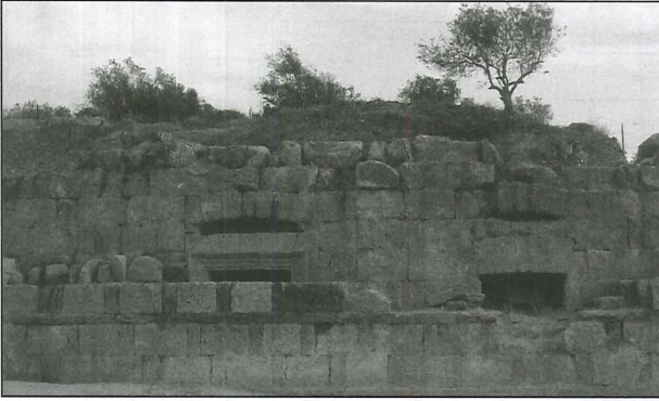
١٥. منظر عام للواجهة الرئيسية الشمالية للمسرح بعد تنظيفها في المنطقة
