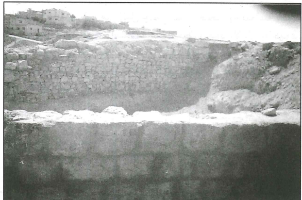
٢. ترميم الجدران المنهارة.
