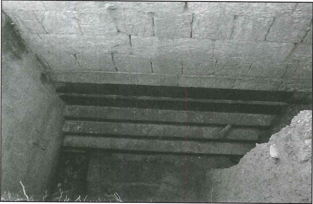
٣١. أساس البناء البازلتي المتدرج في المربع L1.
