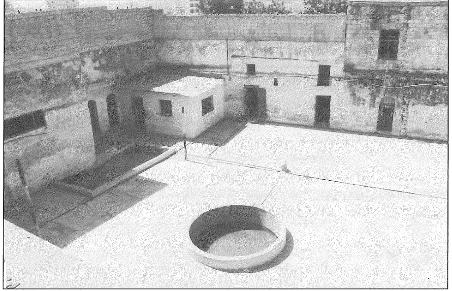
١٧. الساحة الداخلية قبل الترميم.
