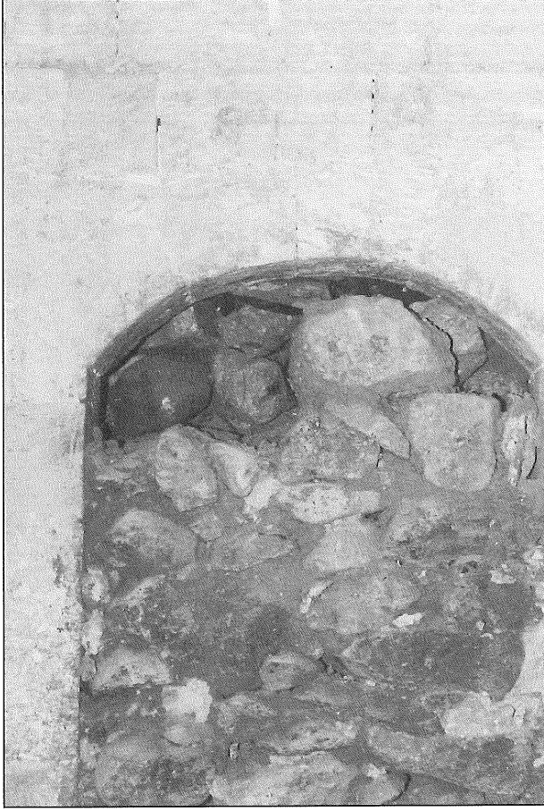
٩. فتحة مغلقة في داخل المبنى.
