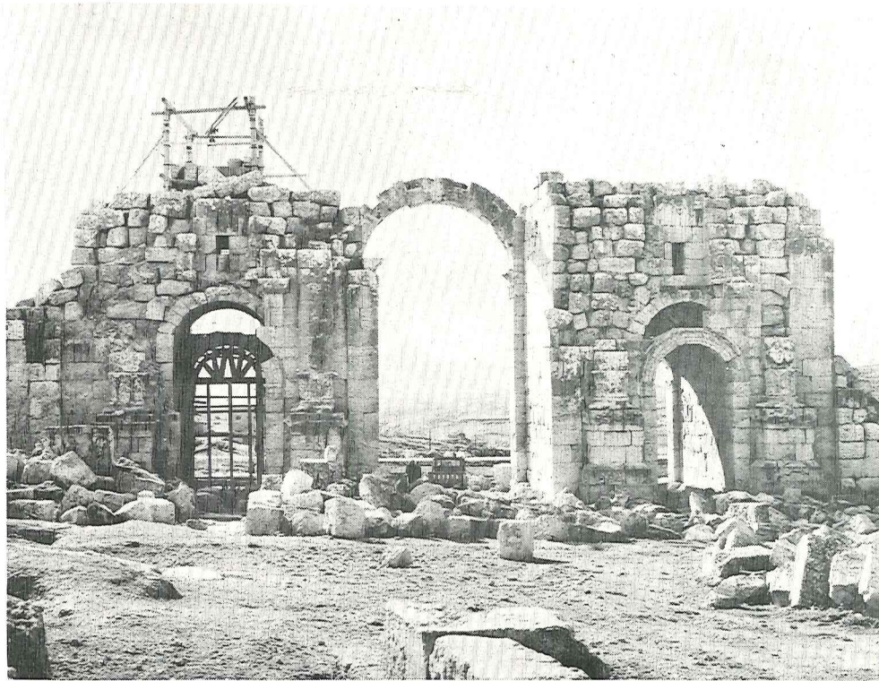
الواجهة الجنوبية للمدرج الجنوبي بجرش
