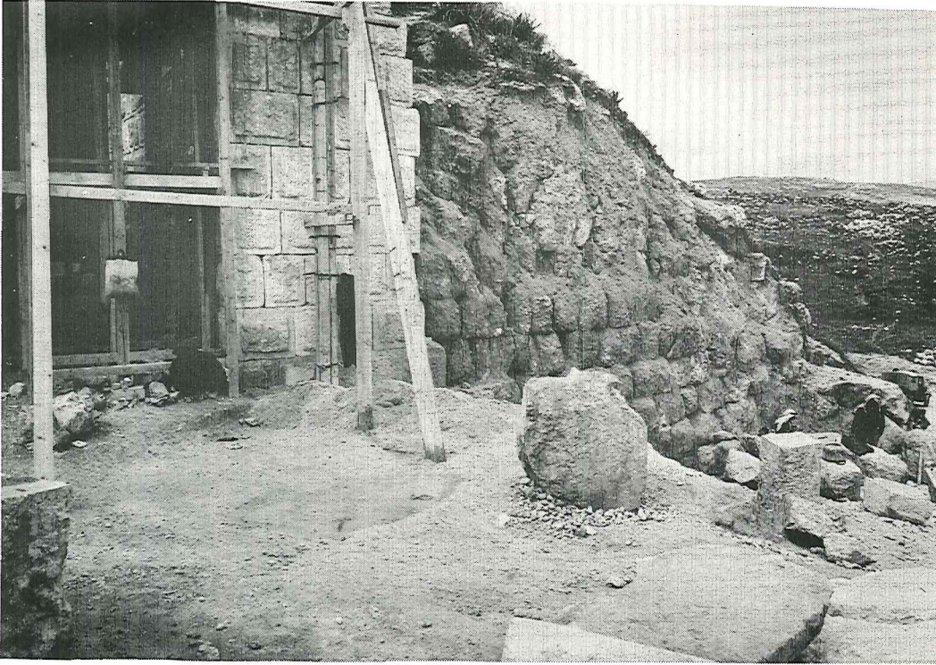
المدراج الجنوبي بجرش - ترميم مدخل المرحلة الثانية
