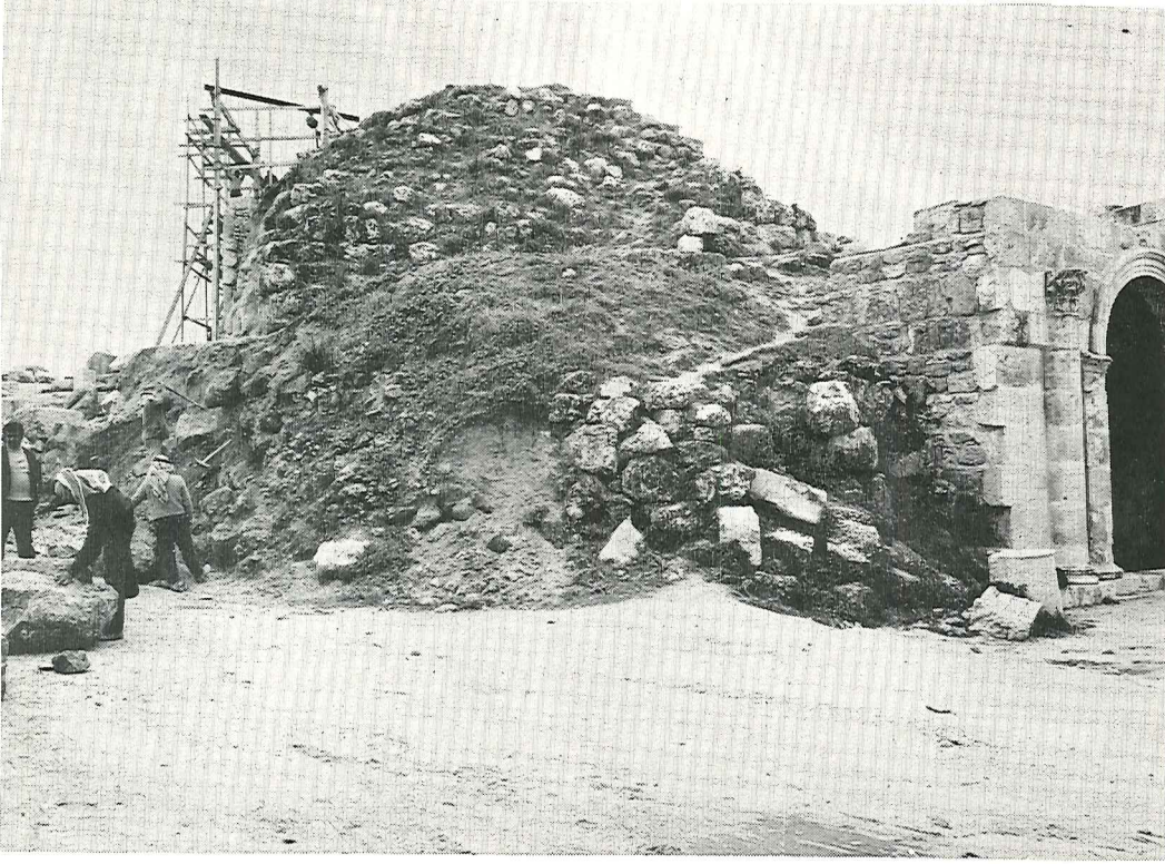
المدرج الجنوبي بجرش - الكشف عن الجدار الخلفي للمدرج
