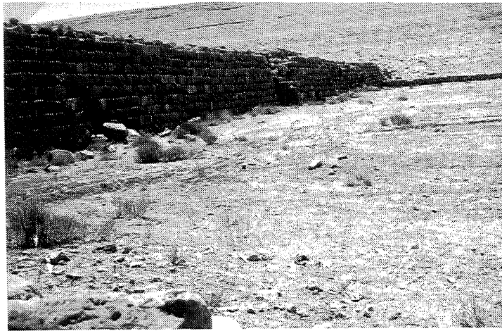
ب - السد الجنوبي الشرقي - منظر عام للواجهة الخارجية .
