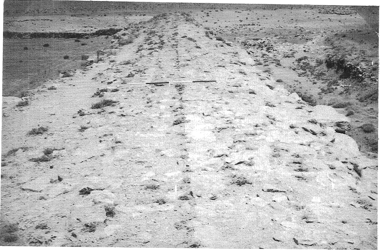
أ - سطح السد الجنوبي الشرقي في القناطر.
