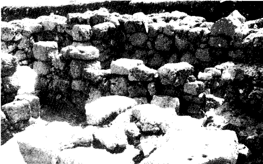
ج- استعملت الدعامات لتقوية الجدران الداخلية في البناء المربع - لاحظ وجود خمس منها في مركز الصورة.
