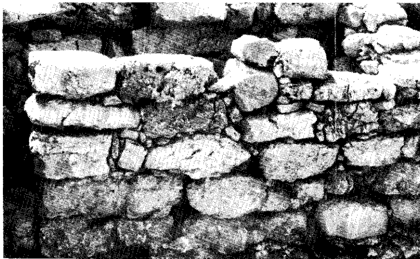
ج- أحد الجدران الداخلية ويظهر على خلفية الصورة الجدار الخارجي حيث تبرز في المدامك العلوي بعض الحجارة التي كانت تشكل قواعد أركان لحجارة السقف.
