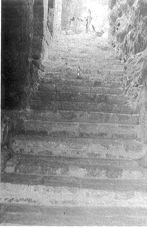
ب- مدخل القلعة الرئيسي: درج القلعة بعد اتمام البناء.
