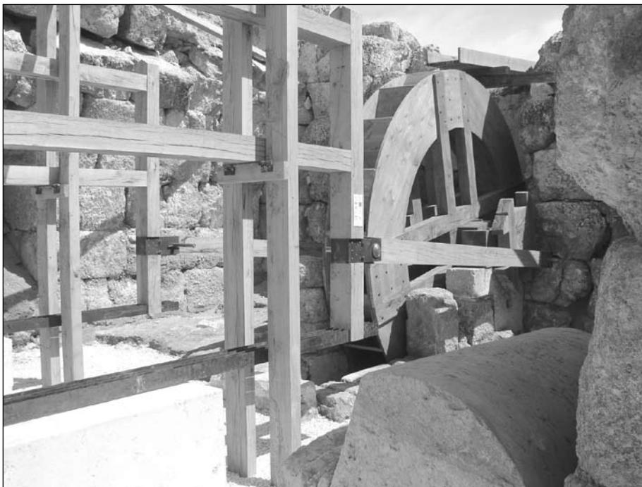
5. Le moulin et l'installation de sciage reconstitués.
