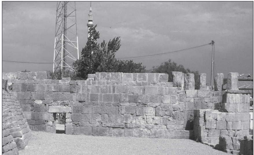
١١. الجدار الغربي من الداخل بعد الترميم.
