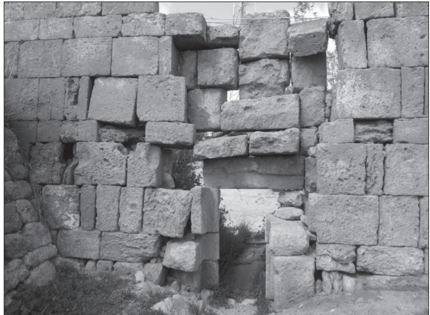
١. مدخل الجدار الغربي من الداخل قبل الترميم.
