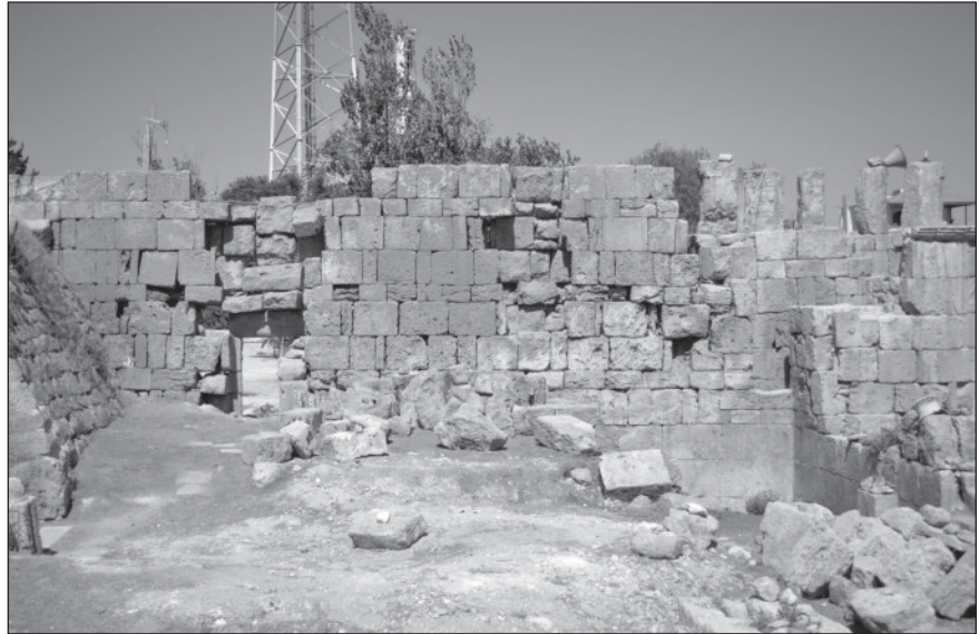
١٠. الجدار الغربي من الداخل قبل الترميم.
