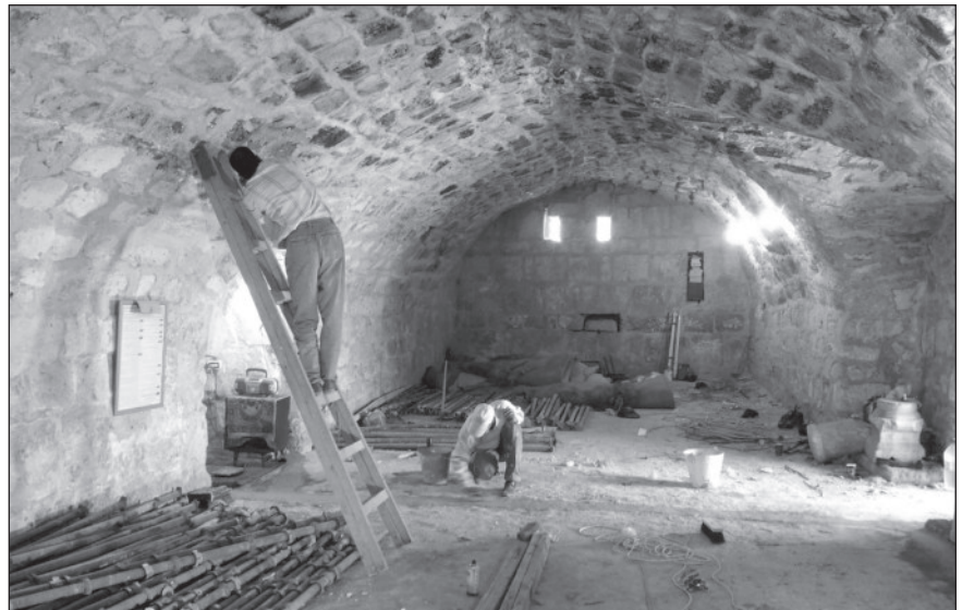
١٧. المسجد من الداخل قبل الترميم.
