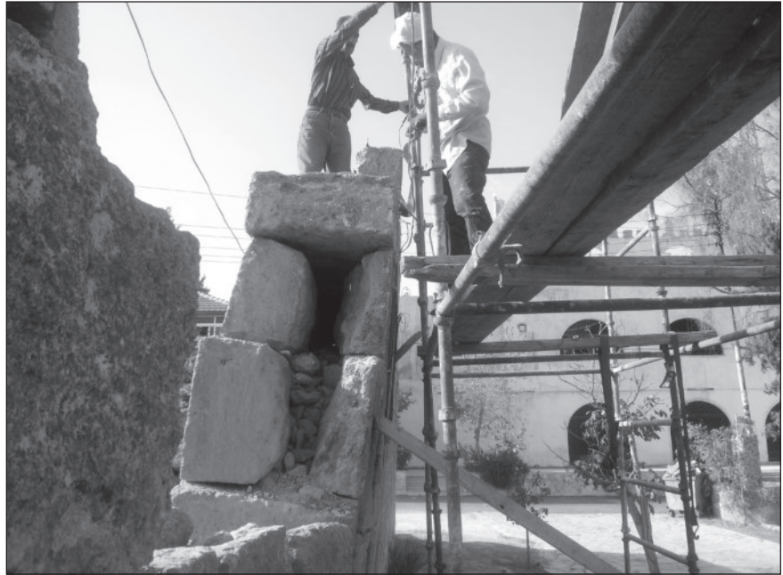
٥. عدم وجود المادة الرابطة بين حجارة الجدار.
