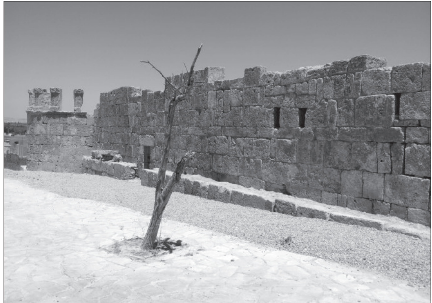
٩. الجدار الغربي بعد الترميم.
