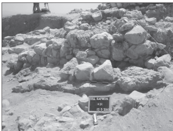
3a. Trench R12.
