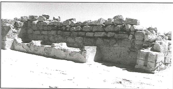
12. Umm al-Walid. L'entrée du qaṣr oriental avec les banquettes à accoudoirs.
