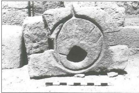
شكل (٨) منظر تفصيلي لقاعدة الزيتون المستقلة، التي تعمل باللولب الضاغظ
