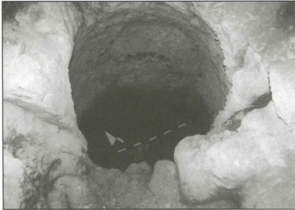
11. G.24 storage silo.
