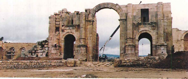
الواجهة الجنوبية لقوس هادريان قبل الترميم
