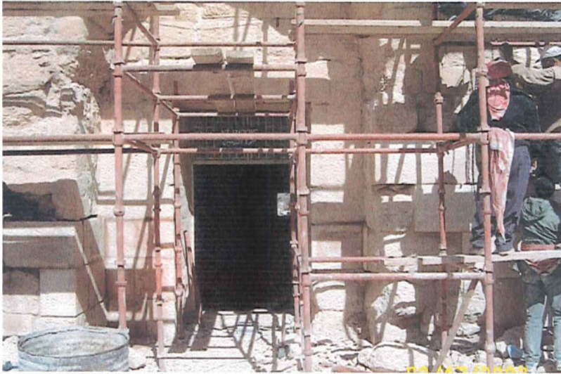
اعمال الترميم للواجهة الامامية للمتحف
