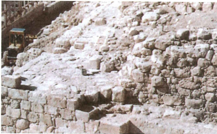
أحد الجدران بعد الترميم
