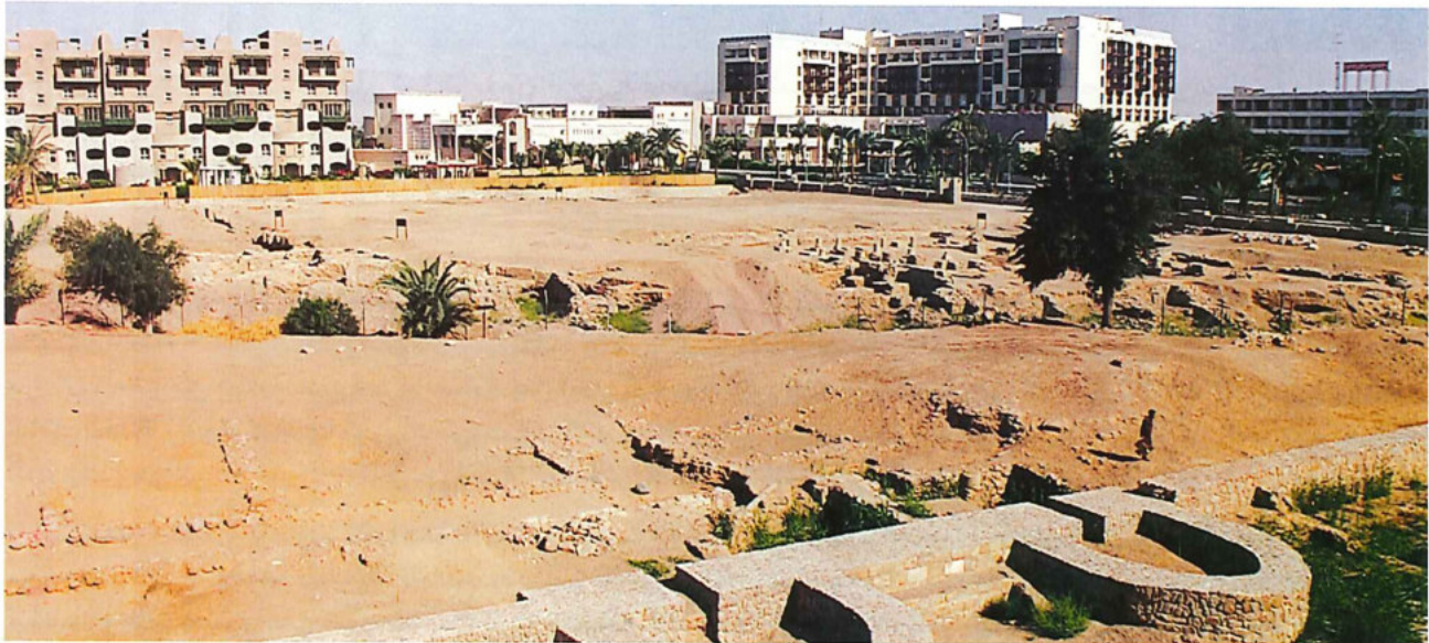
منظر عام لترميم السور الجنوبي للموقع
