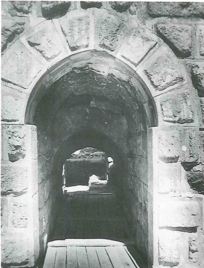
القبو النافذ من الجهة الخلفية الذي جرى عليه أعمال الصيانة والترميم
