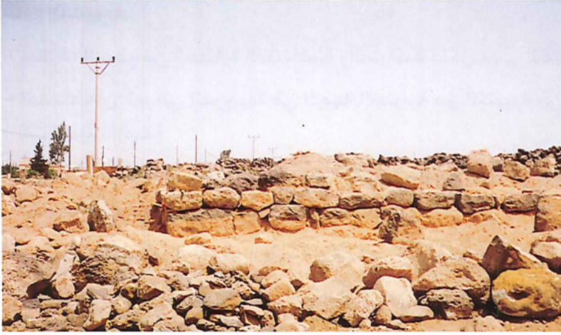
سور المدينة قبل الترميم
