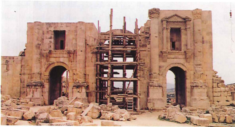
الواجهة الشمالية لقوس هادريان بعد الترميم
