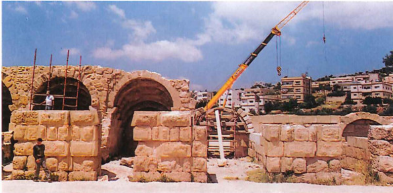
الأقواس الحاملة لدرج المشاهدين اثناء الترميم
