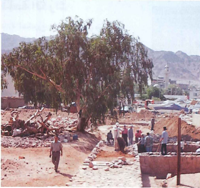
أعمال الترميم لسور المدينة ( أيله )
