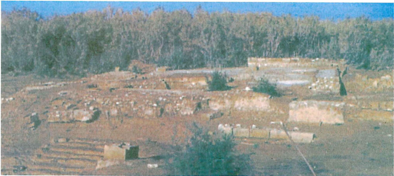
الكنيسة الثالثة من الشرق قبل التدخل بأعمال الترميم
