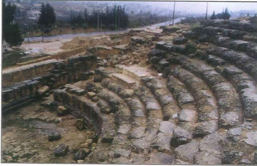
منظر للمدرج أثناء اعمال الترميم في مشروع البركتين
