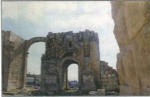
الواجهة الشمالية لبوابة هيدريان قبل الترميم
