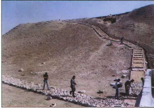
الدرج الصاعد الى التل أثناء اعمال الترميم
