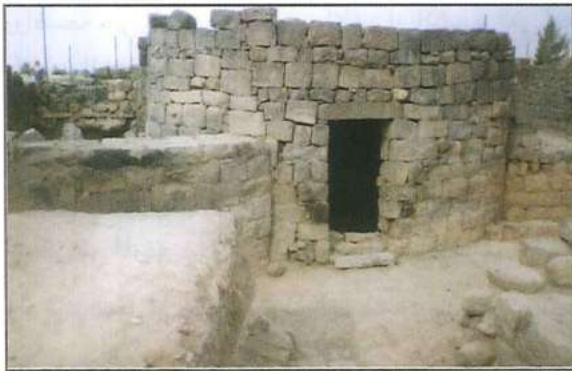
الكنيسة بعد أعمال الصيانة والترميم
