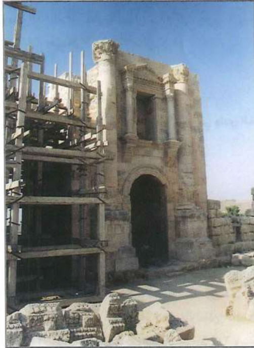
الواجهة الشمالية لبوابة هيدريان بعد الترميم
