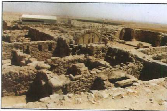
أعمال الصيانة والترميم في كنيسة الأسود
