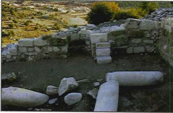
المسجد الأموي بعد الترميم
