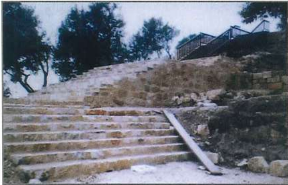
درج الكنيسة بعد الترميم
