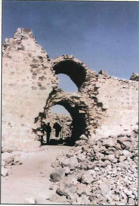
مدخل القلعة قبل الترميم
