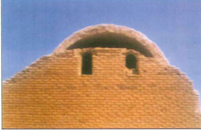
واجهة القصر من الجنوب قبل الترميم
