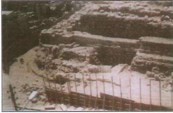
ترميم البرج الجنوبي الشرقي
