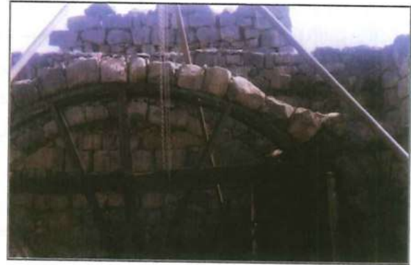
أحد عقود الإسطبلات الشمالية الشرقية أثناء الترميم
