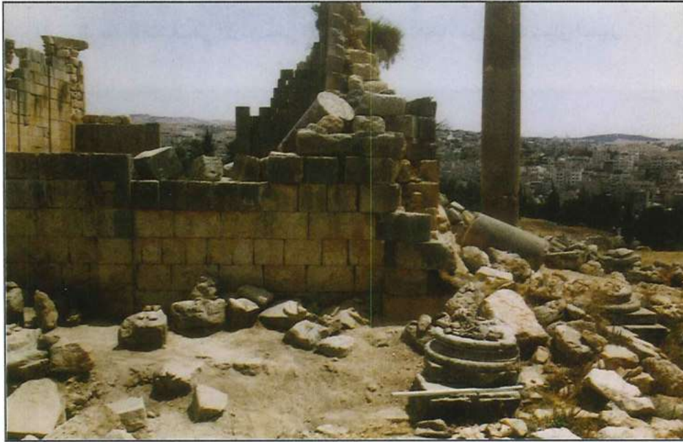
الواجهة الجنوبية لمعبد زيوس أثناء صيانة وترميم قواعد الأعمدة
