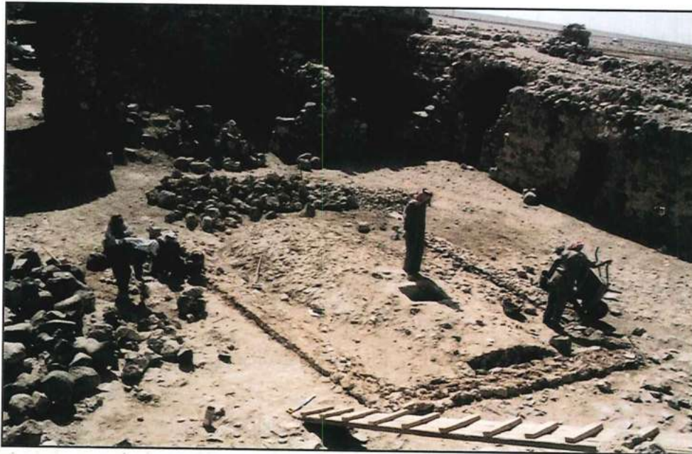
أعمال الترميم في الساحة الداخلية لقلعة عنيزة
