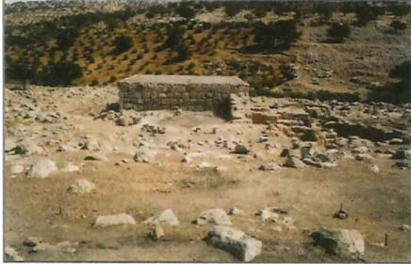
المنزل التراثي بعد الترميم
