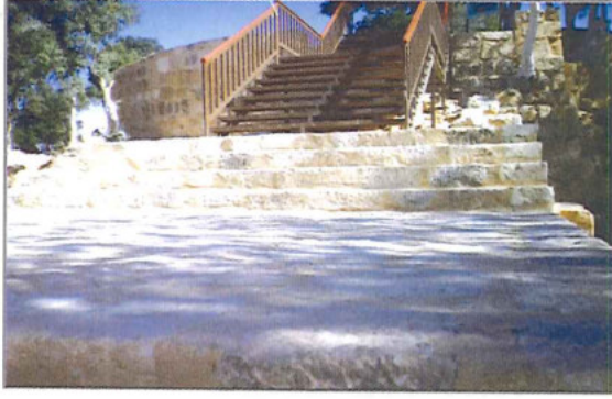
إعادة صيانة وترميم درج الكنيسة
