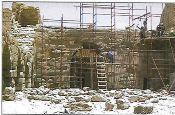
واجهة المتحف أثناء الترميم
