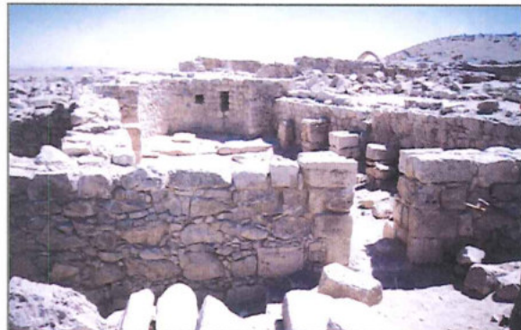
أعمال الترميم في كنيسة الطاووس
