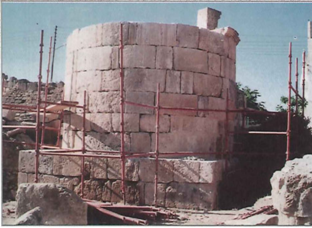
المئذنة اثناء الترميم
