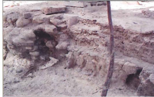
الجدار الشرقي/تظهر طبع الحجارة قبل الترميم
