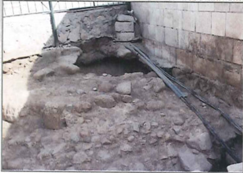
البرج الشمالي الغربي قبل الترميم
