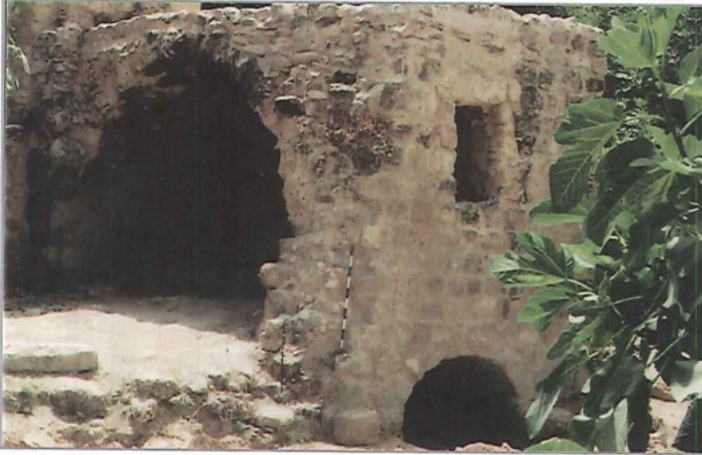
طاحونة عودة قبل الترميم
