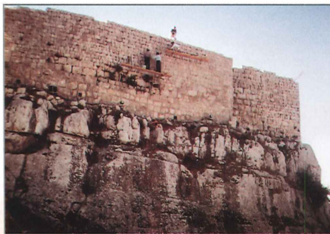
ترميم الواجهة الشمالية للقلعة من الخارج
