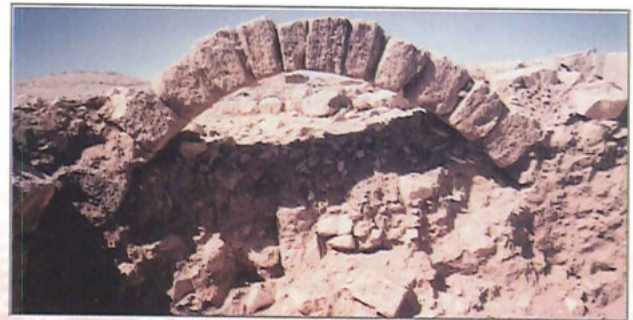
كنيسة اسطفانس قبل الترميم
