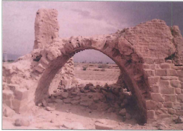
البوابة الجنوبية قبل الترميم
