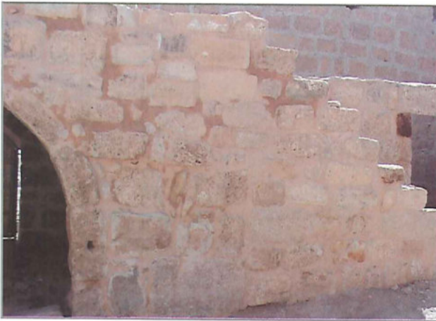
ترميم العقود والأدراج داخل القلعة
