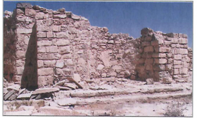
حنية كنيسة الباحة قبل الترميم
