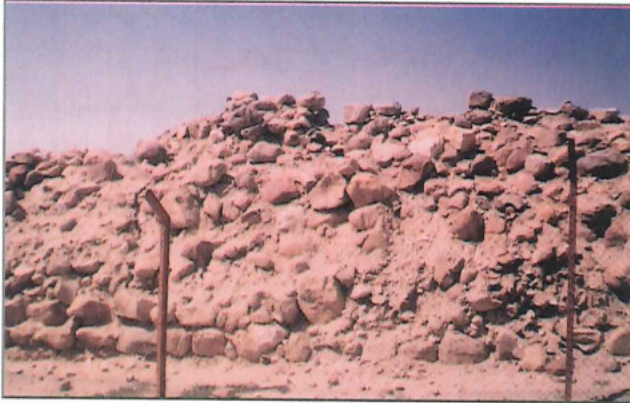
الجدار الشرقي قبل الترميم
