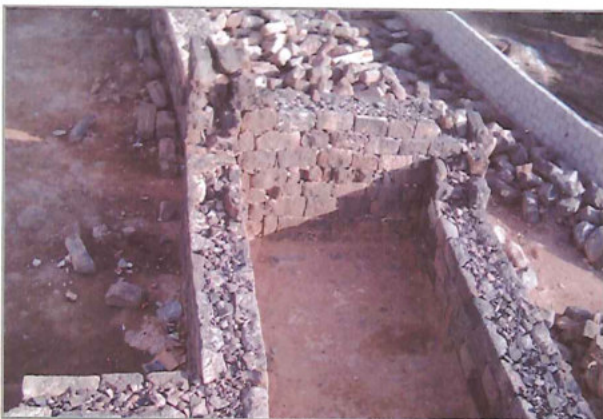
الغرفة رقم ٢ بعد الترميم
