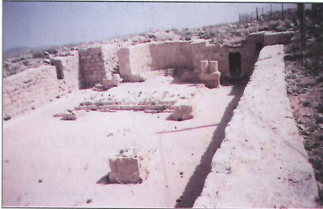
الكنيسة أثناء الترميم
