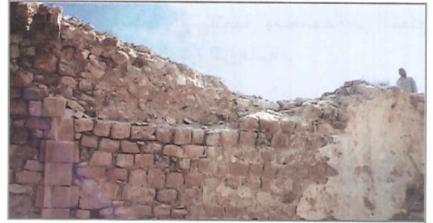
الجدار الشمالي قبل الترميم
