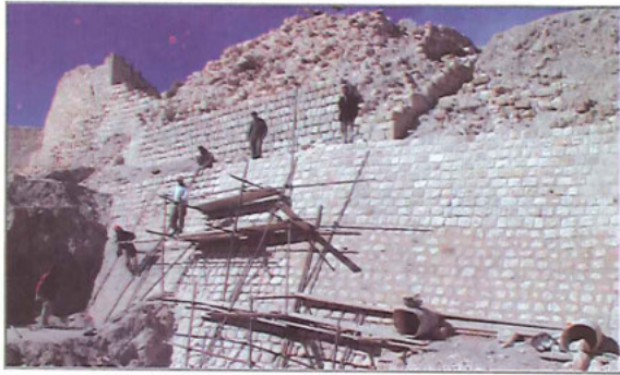
الجدار الجنوبي أثناء الترميم
