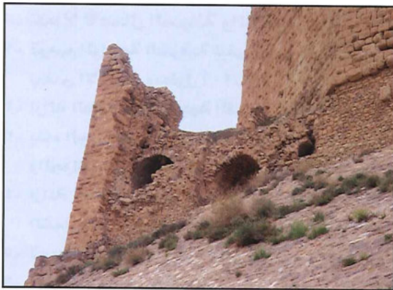
الواجهة الشرقية للزاوية الجنوبية الشرقية قبل الترميم
