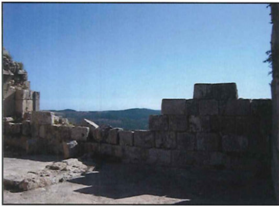
الواجهة الداخلية للجدار الشرقي لبرج أبيك قبل الترميم
