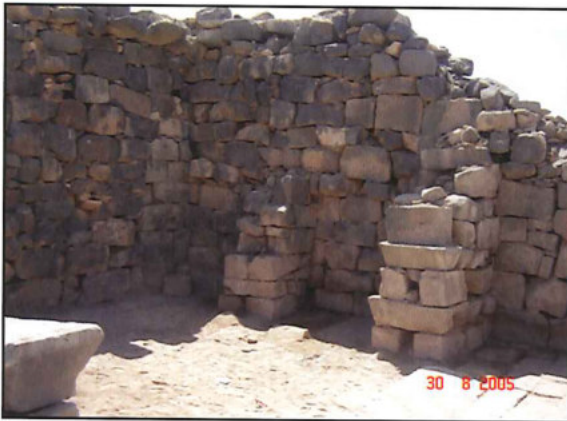
الجدران بعد الترميم
