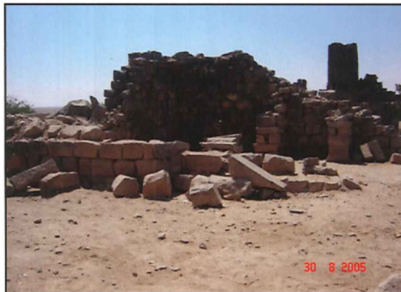
البناء بعد الترميم
