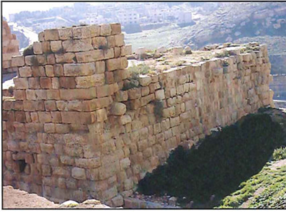
الواجهة الجنوبية للبرج الشرقي قبل الترميم
