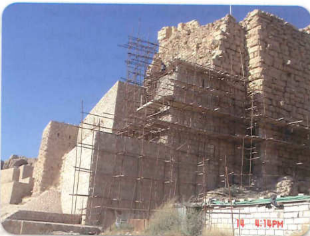
الواجهة الشمالية للبرج الشمالي الشرقي اثناء الترميم
