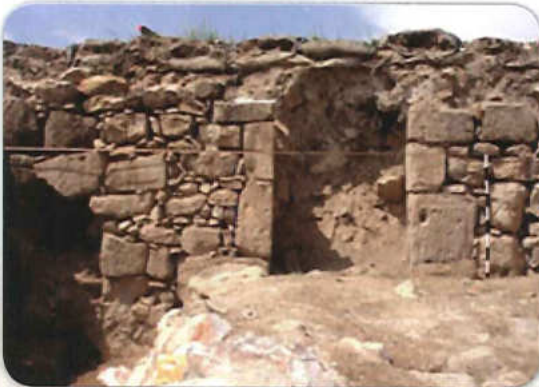
مقطع ١٤ - إحدى الجدران قبل الترميم
