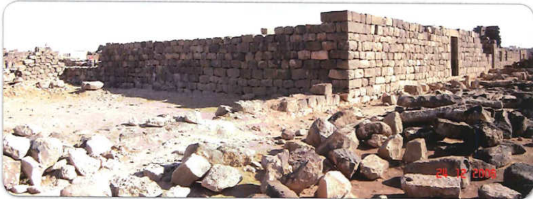
الواجهة الجنوبية الغربية بعد الترميم
