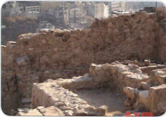
مقطع ١٤ - المنطقة الجنوبية / سور القلعة من الداخل بعد اعمال الصيانة والترميم
