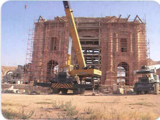
قوس النصر الواجهة الجنوبية الامامية اثناء الترميم
