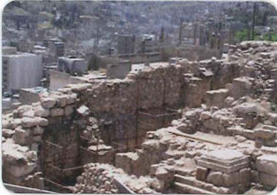
مقطع ١٤ - المنطقة الجنوبية / سور القلعة من الداخل قبل اعمال الصيانة والترميم
