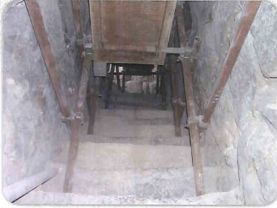
الدرج قبل الترميم
