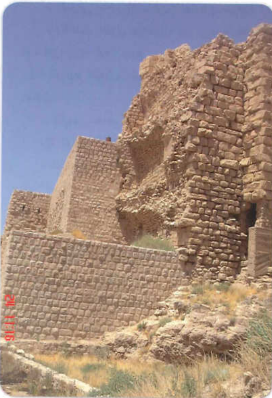
الواجهة الشمالية للبرج الشمالي الشرقي قبل الترميم
