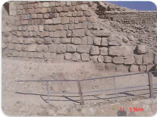
الواجهة الجنوبية بعد ازالة الطمم
