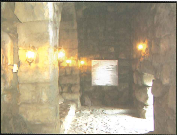
الغرفة رقم ١٣ بعد الترميم
