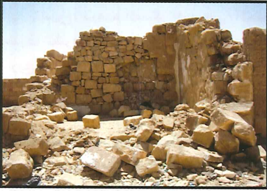
الجدار الخارجي قبل الترميم
