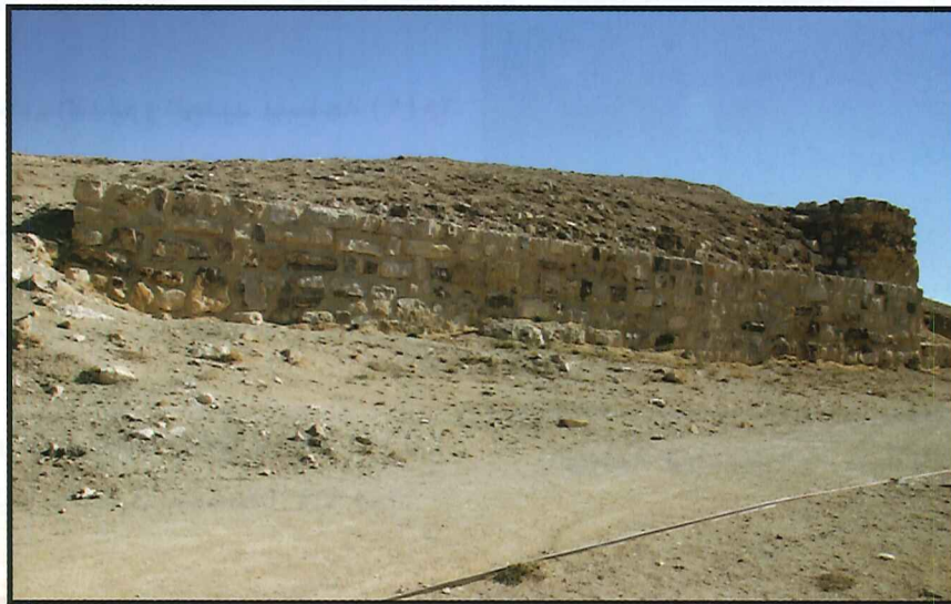
الجدار RW3 بعد الترميم
