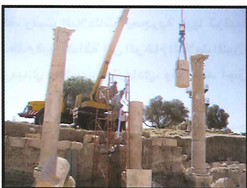
أعمال الترميم للأعمدة
