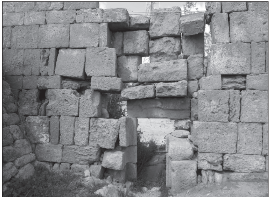
١. مدخل الجدار الغربي من الداخل قبل الترميم.
