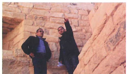
إنتهاء المرحلة الأولى من أعمال الترميم لقلعة القطرانة
