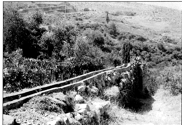
٣. قناة لتزويد طاحونة الحبوب بالماء.
