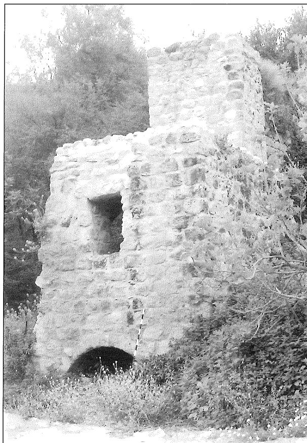
١٨. طاحونة عودة قبل أعمال الترميم وإعادة البناء.
