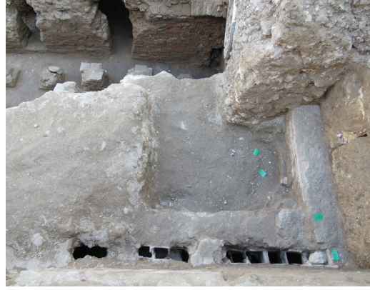
4. القنوات الفخارية المربعة المستخدمة لنقل الهواء الساخن من الفرن إلى باقي أجزاء الحمام.
