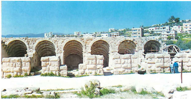
الأقواس الحاملة لدرج المشاهدين بعد الترميم
