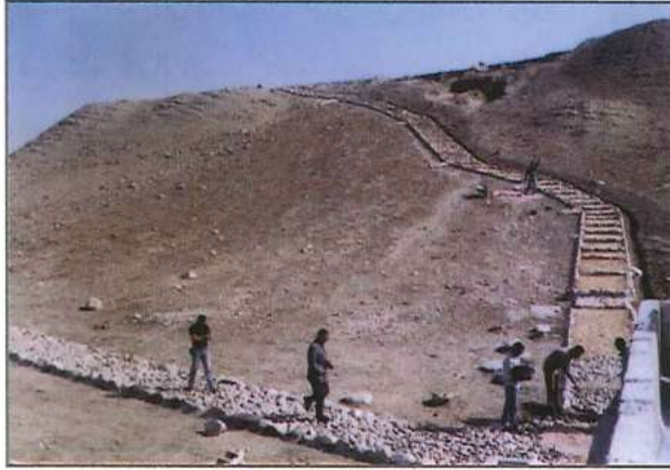
الدرج الصاعد الى التل أثناء اعمال الترميم
