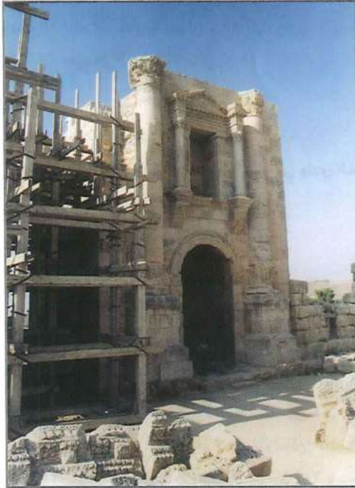
الواجهة الشمالية لبوابة هيدريان بعد الترميم
