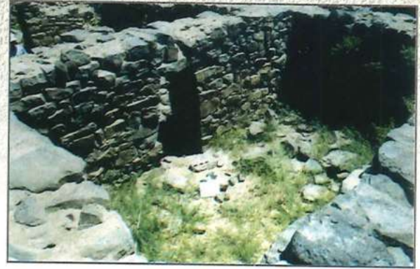
احدى غرف القصر قبل اعمال الصيانة والترميم
