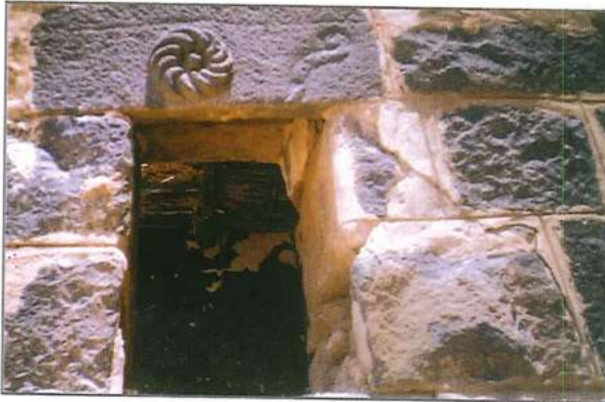
مدخل أحد المباني التراثية في موقع الطرة
