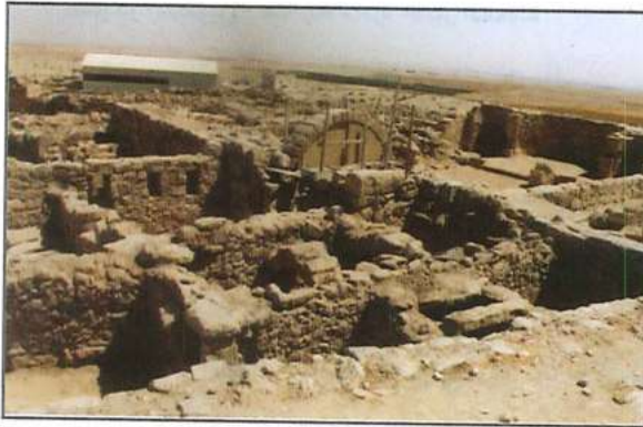
أعمال الصيانة والترميم في كنيسة الاسود
