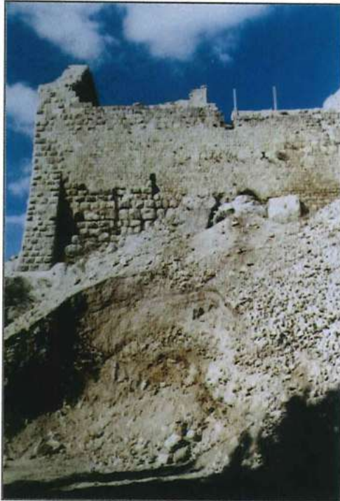
أعمال الصيانة في الخندق المحيط بالقلعة
