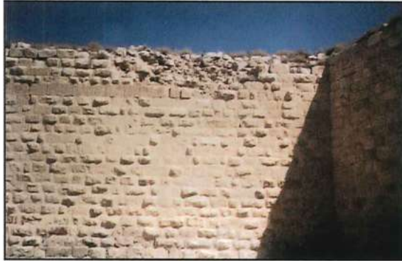
الواجهة الشرقية للجدار الغربي من البرج
