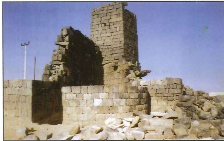
برج كنيسة جورج أثناء الترميم
