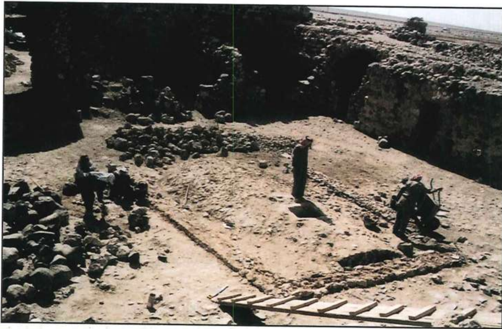
أعمال الترميم في الساحة الداخلية لقلعة عنيزة
