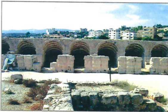
ملعب سباق الخيل - العقود الحاملة للمدرج بعد الترميم من الخارج
