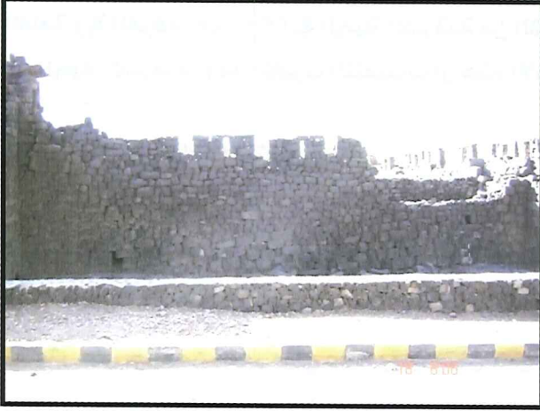
الجدار قبل الترميم
