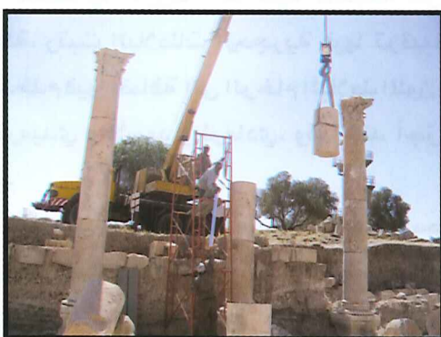
أعمال الترميم للأعمدة
