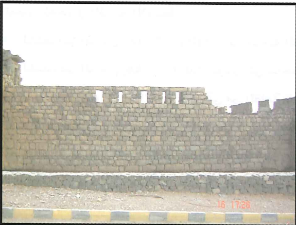
الجدار بعد الترميم
