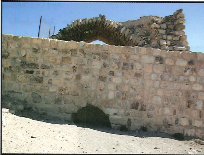
الواجهة الجنوبية الخارجية للكنيسة بعد الترميم
