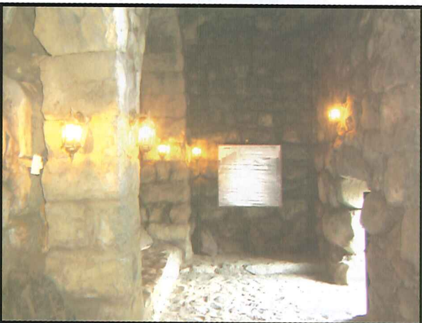
الغرفة رقم ١٣ بعد الترميم
